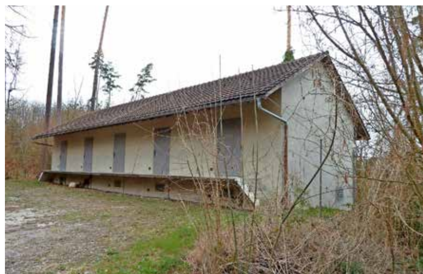
Der Bund bietet das nicht mehr benötigte Munitionsmagazin im Wald zwischen Wilen und Oberstammheim jetzt als Schnäppchen zum Kauf an.
